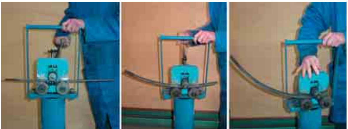
Fig. 6.3 Het rondbuigen van stripijzer met een wals
