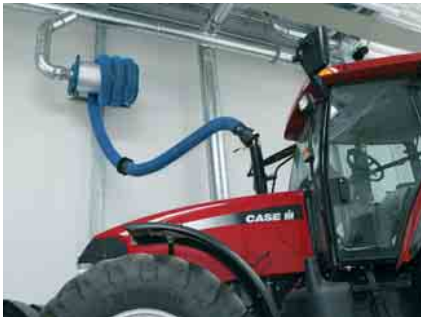
Fig. 14.6 Een rookgasafzuiging
