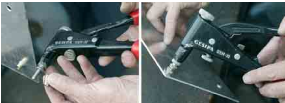
Fig. 11.12 Het plaatsen van een intrekmoer
